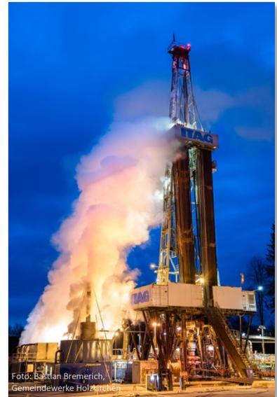
**Abb. 7:** Bohrturm beim Pumpversuch
