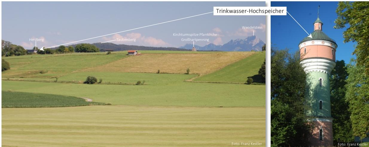
**Abb. 7:** Linkes Bild: Lage des Hochspeichers Herzberg auf dem Kamm des Moränenwalls vom Standpunkt der Tafel S6 aus. Rechtes Bild: In Regionen mit geringeren Reliefunterschieden wie in der Münchner Schotterebene werden Türme errichtet, um darauf Hochspeicher für Trinkwasser zu platzieren. Das Bild zeigt den über 100 Jahre alten Wasserturm in Deisenhofen (Oberhaching), der aber nicht mehr in Betrieb ist.
