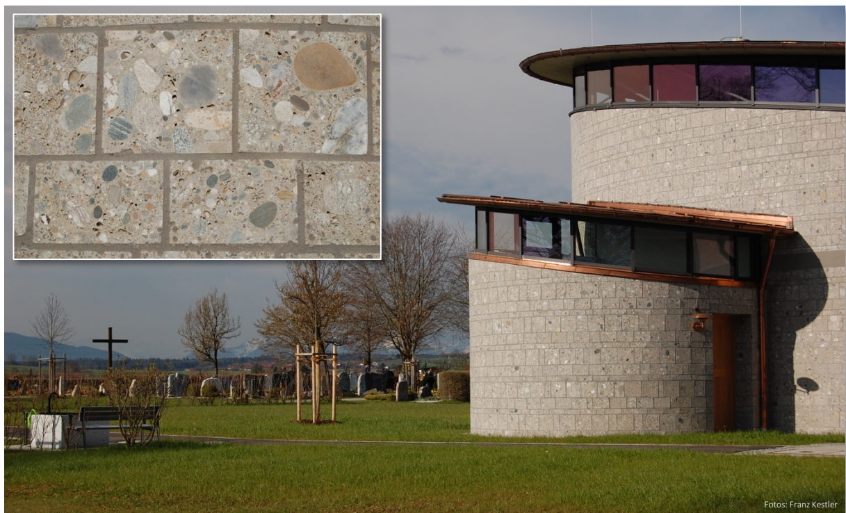
Abb. 11: Die Natursteinverkleidung der Aussegnungshalle des Friedhofs an der Thanner Straße besteht aus Brannenburger Nagelfluh. Diese wird im Inntal abgebaut und weist deshalb durch den Einfluss des ehemaligen Innigletschers einen höheren Anteil an kristallinen Gesteinen (Gneis, Granit) aus den Zentralalpen auf als die Nagelfluh im Bereich des Tölzer Gletscherlobus. Dessen Einzugsbereich war weitgehend auf die nördlichen Kalkalpen begrenzt.
