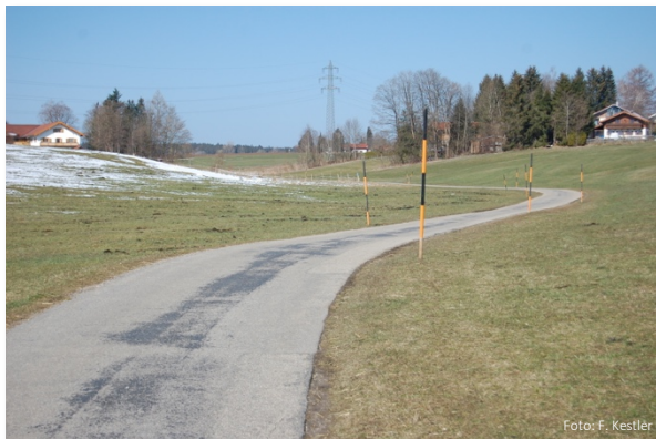
F 3: Aufnahme Richtung W am Ende der Flinspachstraße (24. März 2021)
