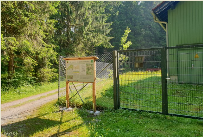
Pumpstation im Teufelsgraben
