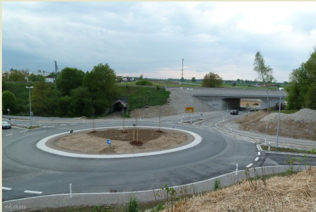
Kreisel an der Alten Au. Links vom neuen Tunnel ist noch der alte, nun zu- geschüttete Tunnel zu sehen
