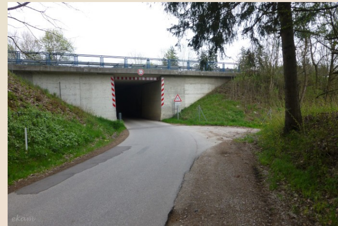
Kleiner Tunnel unter Autobahn
