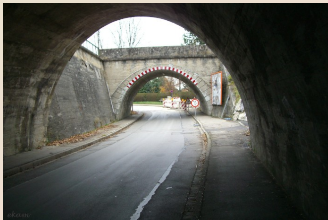
Eisenbahn-Doppel-Tunnel an der Erbkamer Straße
