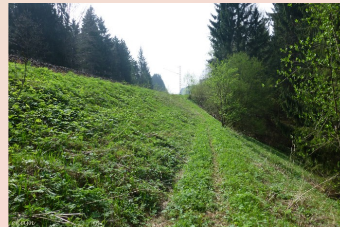
Hoher, steiler Bahndamm
