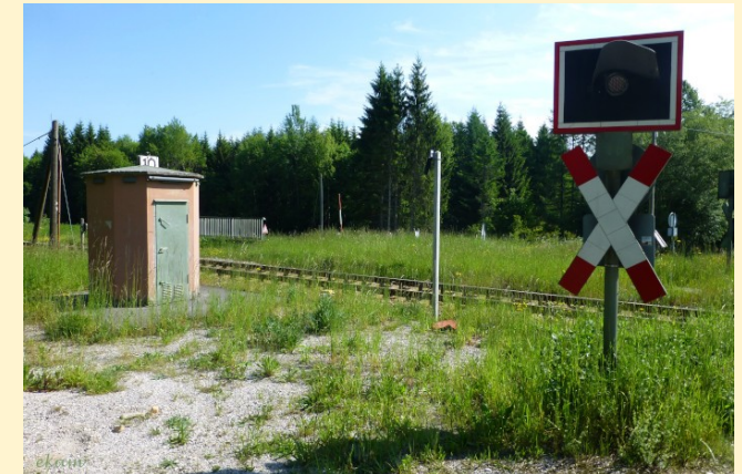
Einige Meter hinter dem Häuschen unterquert der Farnbach die Bahnstrecke
